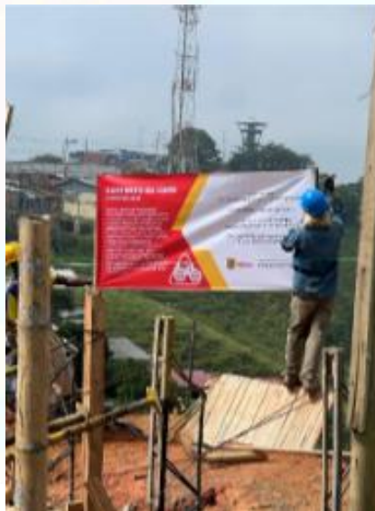
Ilustración 10, Instalación valla informativa Altagracia.
