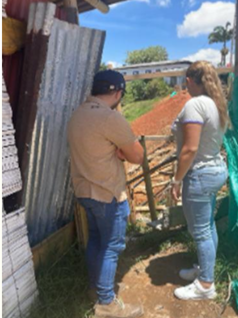
Ilustración 6, Recorrido de Obra
