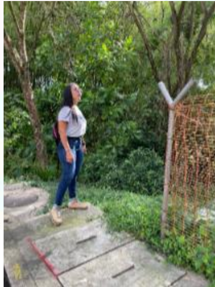
Ilustración 14, Recorrido de obra asesora social contratista Belmonte.
