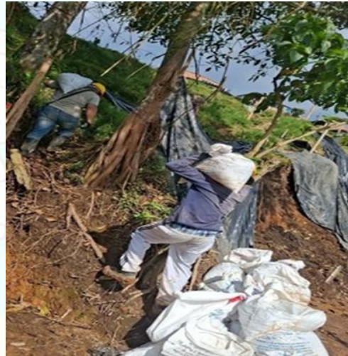
Ilustración 8. Cargue manual para retiro de material de excavación
